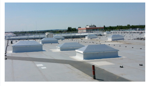
Lichtkuppeln mit Lochblechüberbauung
